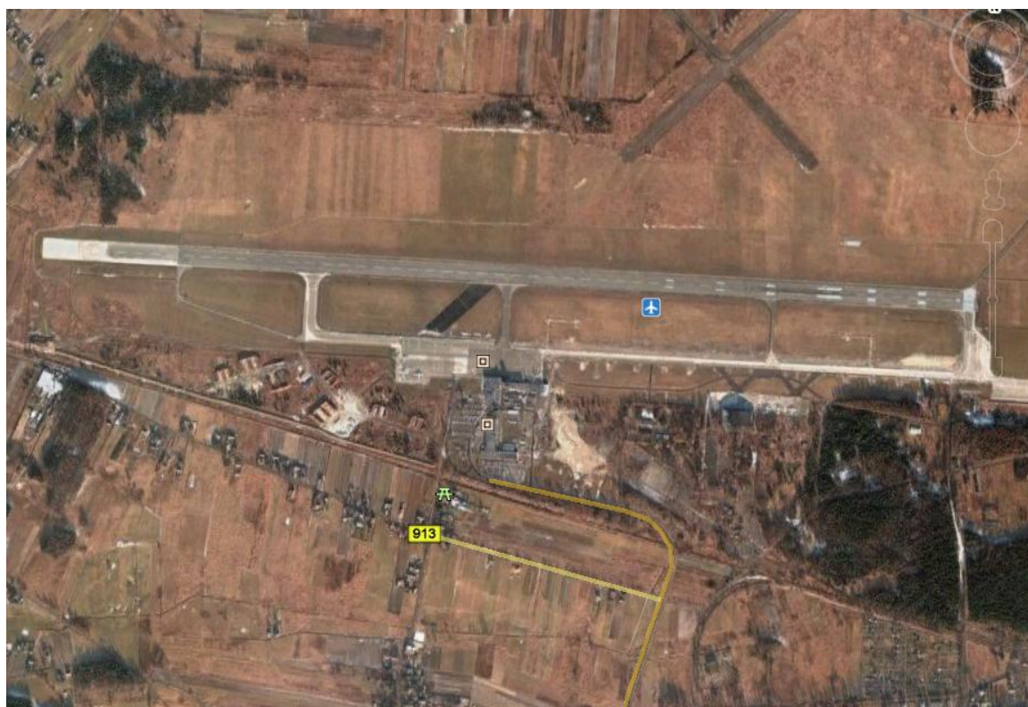
Rys. 4. Międzynarodowy Port lotniczy Katowice – Pyrzowice (EPKT), nawierzchnia betonowa, droga startowa 2800 x 60, RWY 09/27
