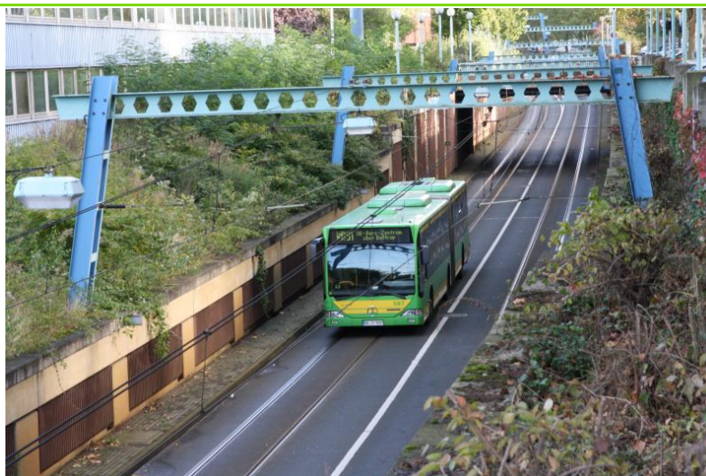
Zdjęcie 8. Szybki tramwaj w Oberhausen posiada wyasfaltowane torowisko, dzięki czemu mogą po nim kursować również autobusy.
